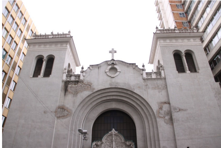
Fachada de la Capilla de San Juan de Dios Fotografías: Fundación “emegece” 2010
